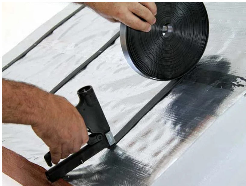
Figura 6. Fixação da manta utilizando fixador de polipropileno.
