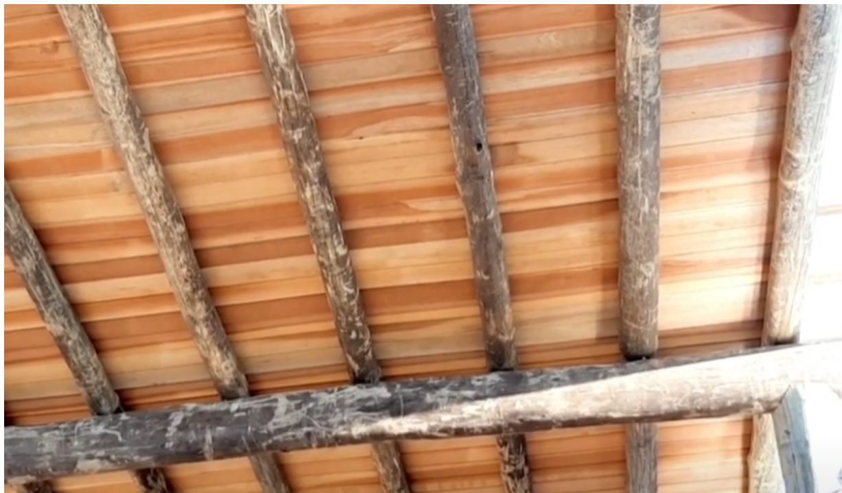
Figura 14. Exemplo de forro fixado sobre os caibros de madeira roliça.
