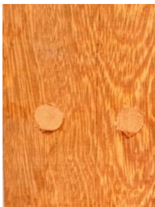
Figura 4. Cavilhas para esconder parafusos.
