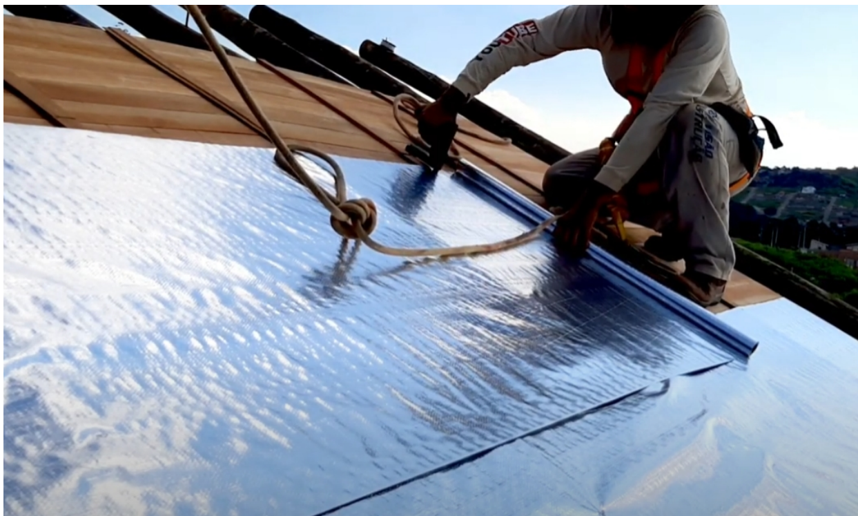
Figura 16. Fixação da manta de subcobertura.
